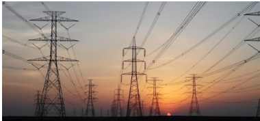
현대건설이 수행한 사우디 리아드 380kV 송전선로 건설 프로젝트 사진. (제공=현대건설)
