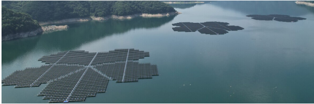
소양강댐 상류에 설치된 양구 수상태양광 전경. (제공=동서발전)
